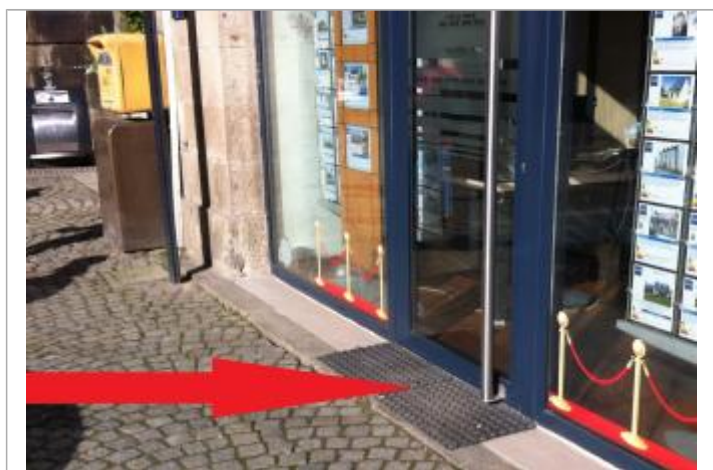
Seuil à l'entrée de l'agence - Photographie DHE 2015
