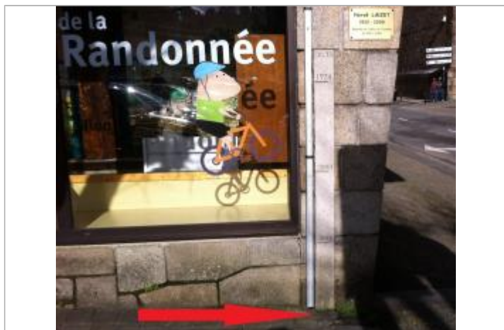
Echelle de crue en granite sur le pavillon de la randonnée - Photographie DHE 2015
