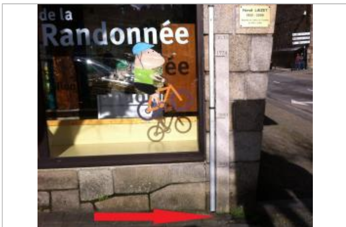
Echelle de crue en granite sur le pavillon de la randonnée
