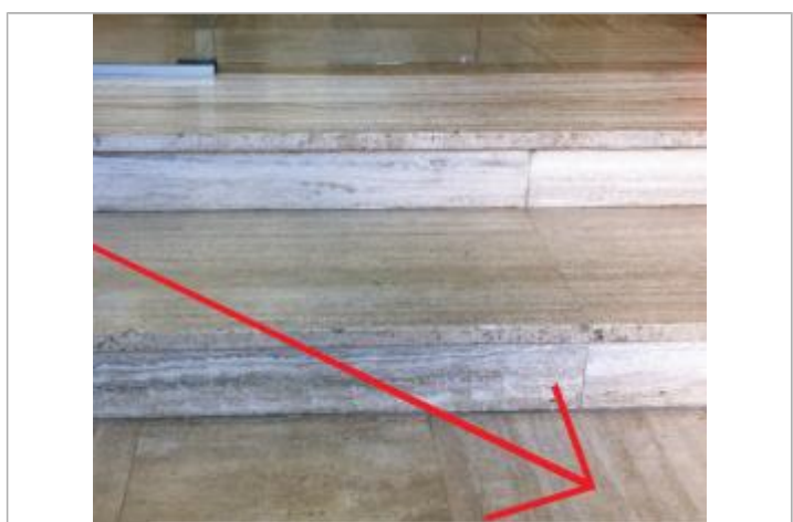
Seuil d'entrée au droit de la première marche - Photographie DHE 2015
