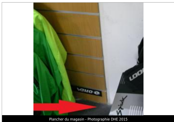
Plancher du magasin - Photographie DHE 2015
