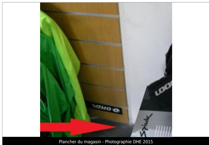
Plancher du magasin - Photographie DHE 2015
