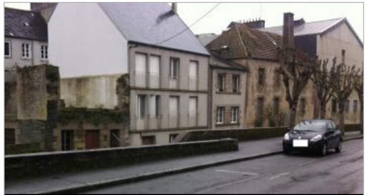
Marches d'accès au quai au niveau du n°1 allée Poan Ben - Photographie DHE 2015
