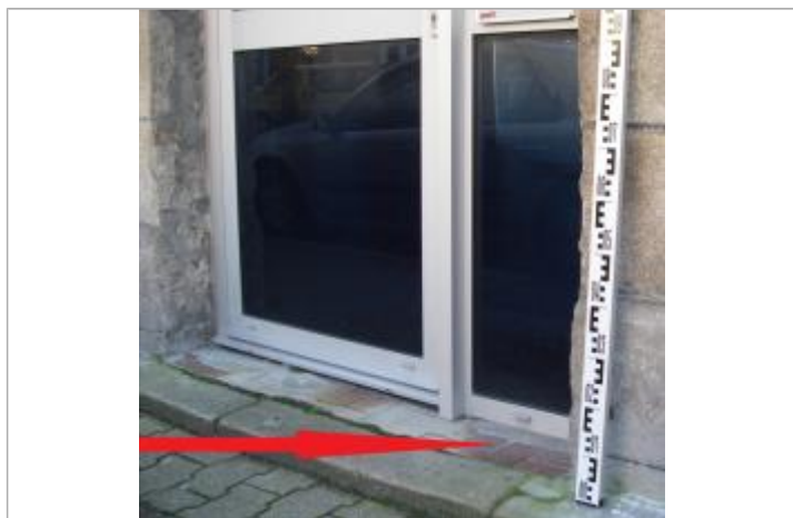
Seuil à l'entrée de l'agence - Photographie DHE 2015
