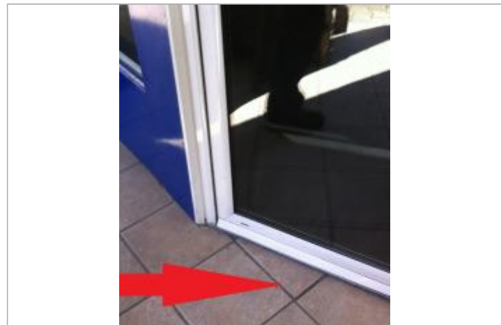
Sol à l'extérieur de la porte d'entrée de l'agence - Photographie DHE 2015
