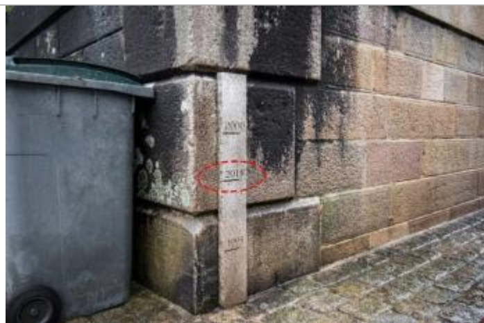
report de la laisse de crue sur l'échelle de granit existante
