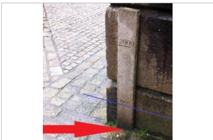
Echelle de crue en granite sous le viaduc ferroviaire - Photographie DHE 2015
