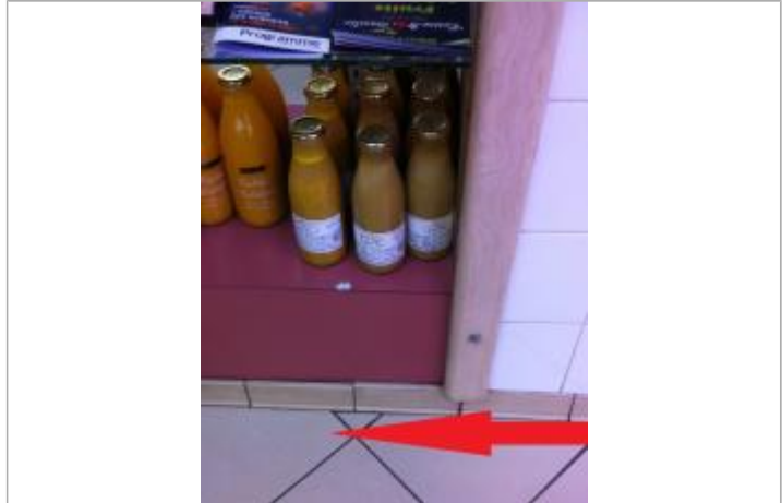
Sol à l'intérieur du magasin - Photographie DHE 2015
