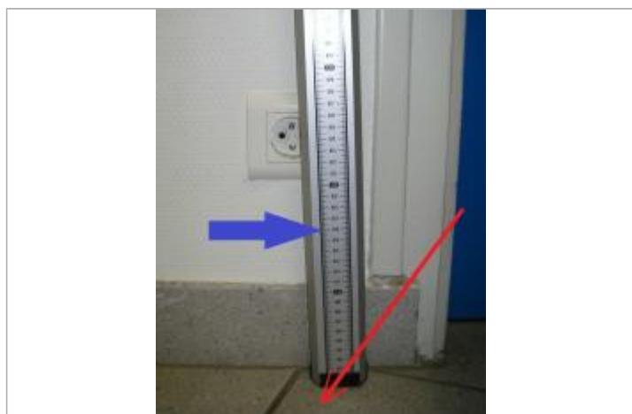
sol à l'intérieur près de la prise électrique
