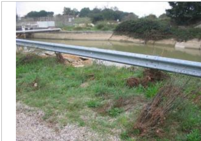
Vue du site - Auteur : Hydro Logik Ingénierie
