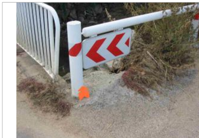
Photo du site - Auteur : Hydrologik Ingénierie
