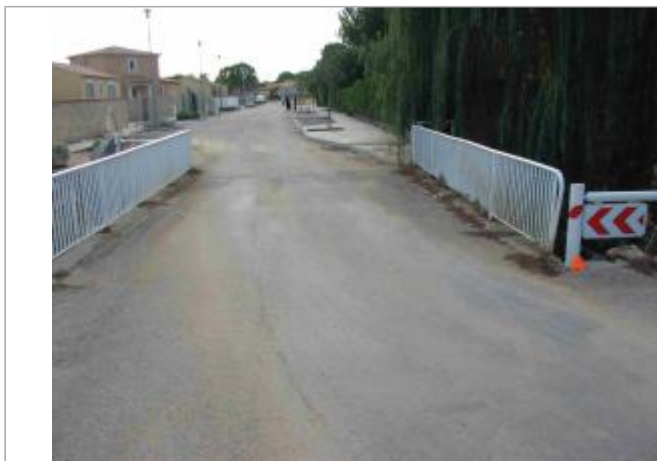
Vue du site - Auteur : Hydro Logik Ingénierie
