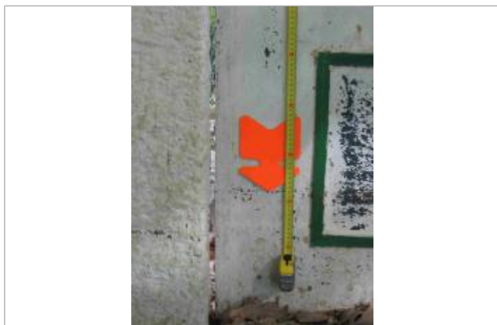
Photo du site - Auteur : Hydrologik Ingénierie
