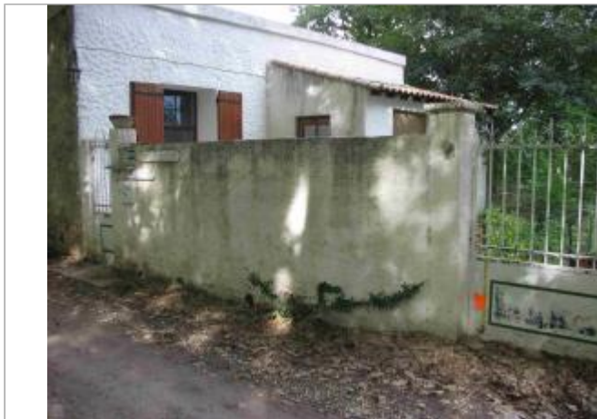
Vue du site - Auteur : Hydro Logik Ingénierie
