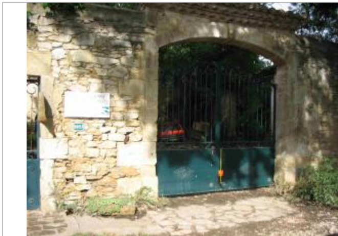
Vue du site - Auteur : Hydro Logik Ingénierie
