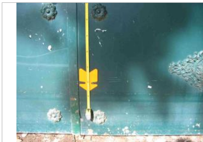
Photo du site - Auteur : Hydrologik Ingénierie
