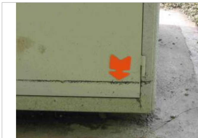
Photo du site - Auteur : Hydrologik Ingénierie
