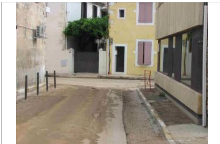
Vue du site - Auteur : Hydro Logik Ingénierie
