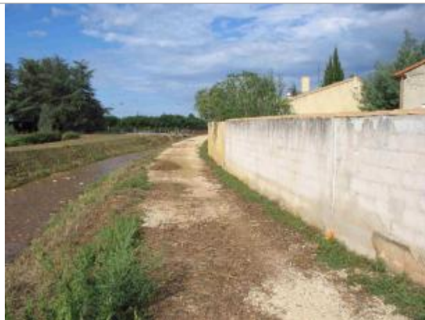
Vue du site - Auteur : Hydro Logik Ingénierie
