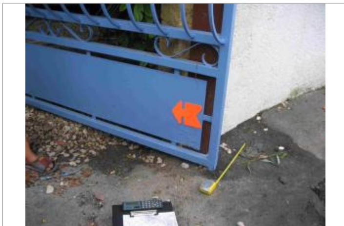
Vue du site - Auteur : Hydro Logik Ingénierie
