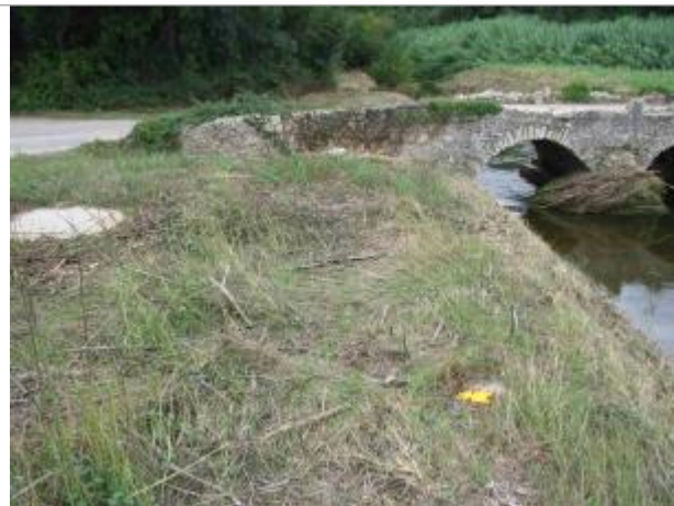
Vue du site - Auteur : Hydro Logik Ingénierie
