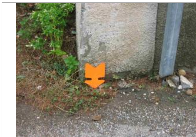
Photo du site - Auteur : Hydrologik Ingénierie
