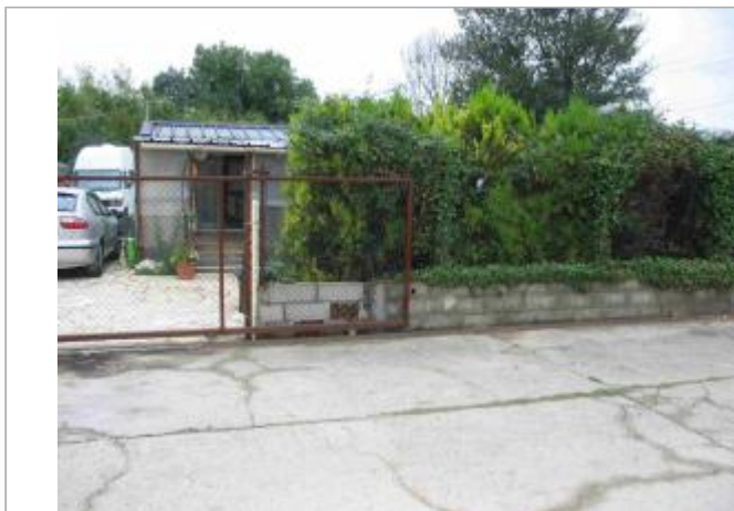
Vue du site - Auteur : Hydrologik Ingénierie
