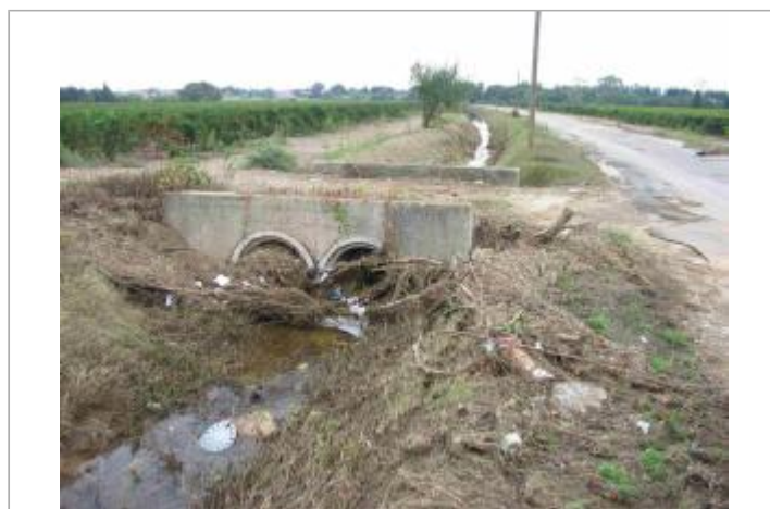
Vue du site - Auteur : Hydrologik Ingénierie
