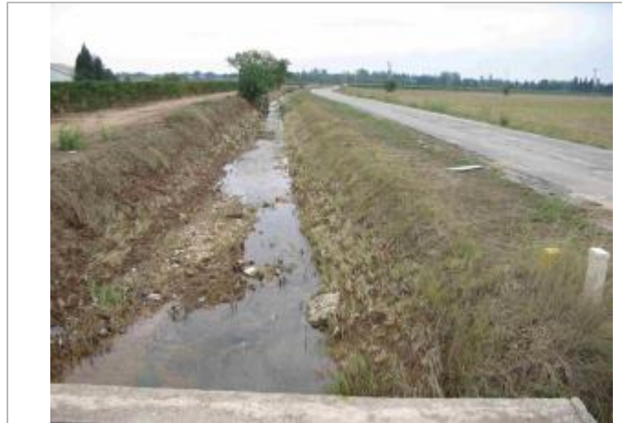
Vue du site - Auteur : Hydrologik Ingénierie
