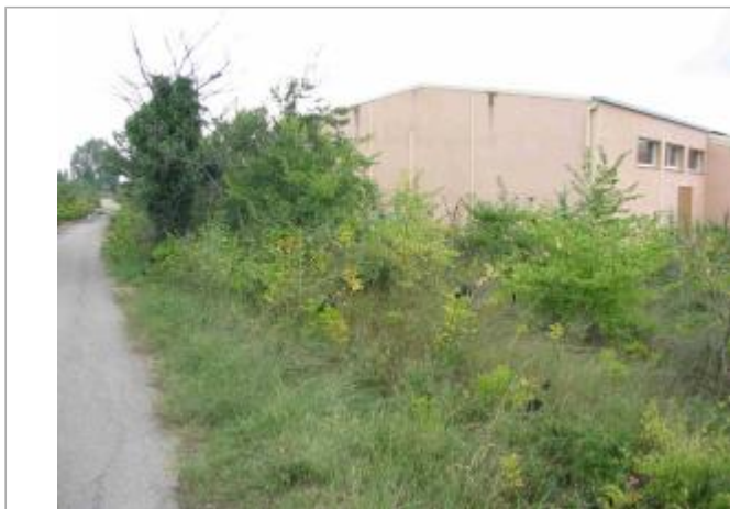
Vue du site - Auteur : Hydrologik Ingénierie
