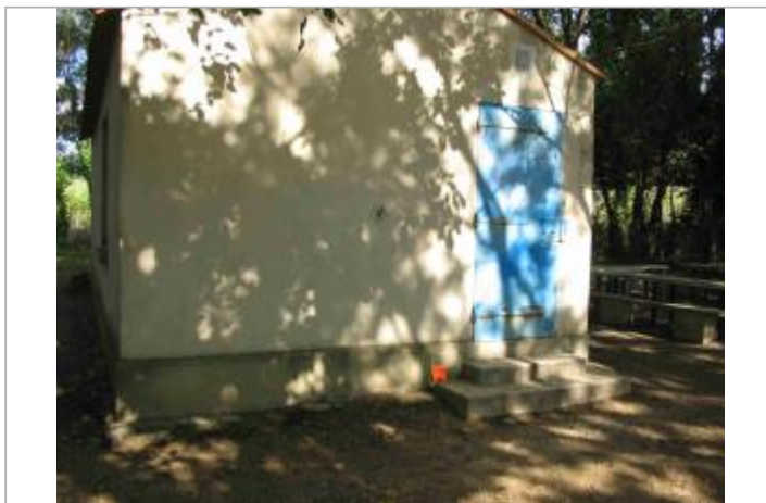
Vue du site - Auteur : Hydrologik Ingénierie
