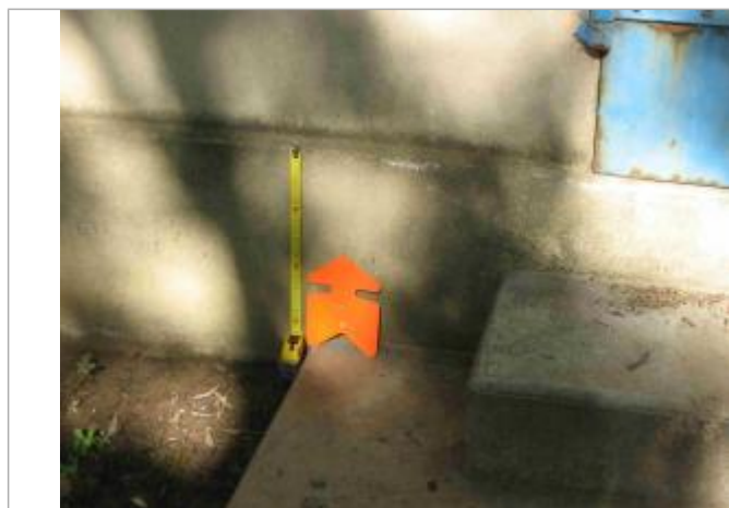
Photo du site - Auteur : Hydrologik Ingénierie
