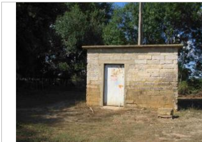
Vue du site - Auteur : Hydrologik Ingénierie
