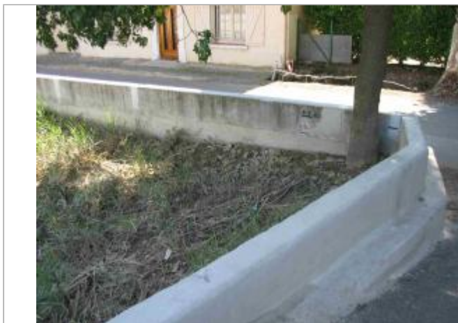
Vue du site - Auteur : Hydrologik Ingénierie
