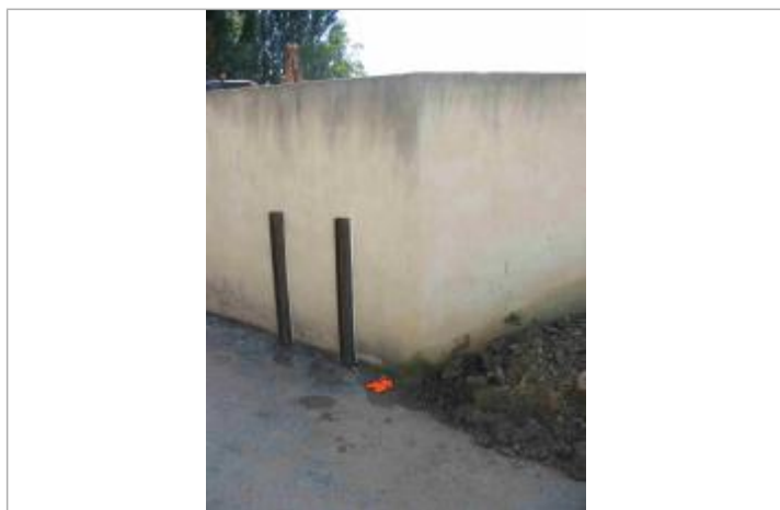
Photo du site - Auteur : Hydrologik Ingénierie
