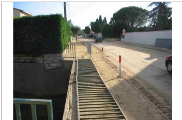
Vue du site - Auteur : Hydrologik Ingénierie
