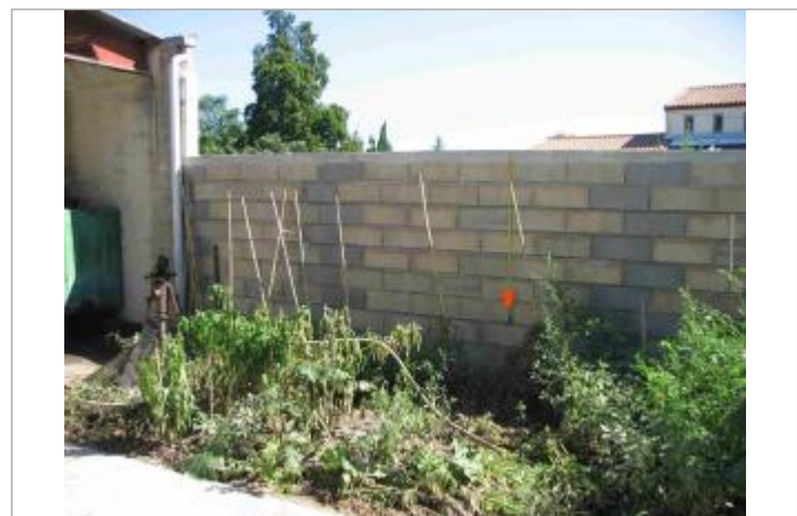
Photo du site - Auteur : Hydrologik Ingénierie
