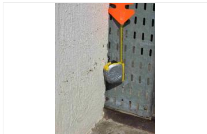
Photo du site - Auteur : Hydrologik Ingénierie
