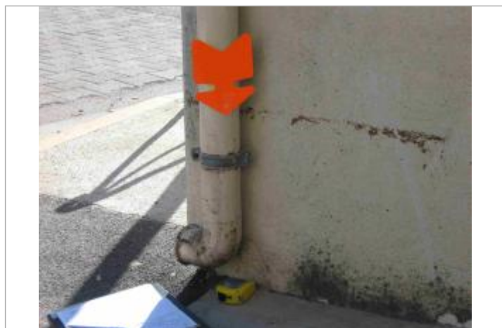
Photo du site - Auteur : Hydrologik Ingénierie
