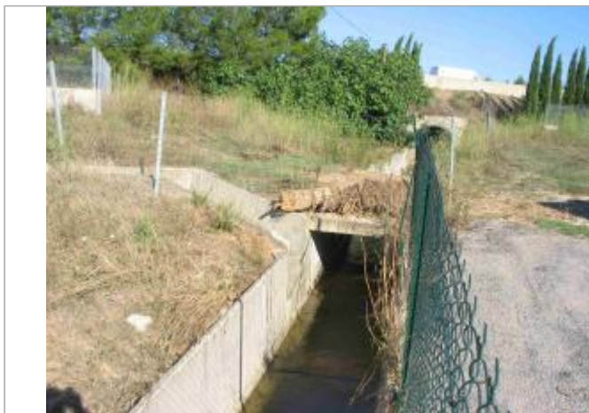
Vue du site - Auteur : Hydrologik Ingénierie
