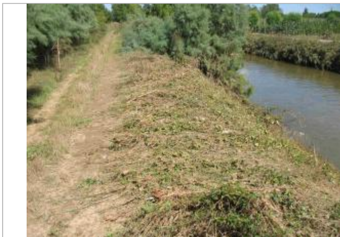
Vue du site - Auteur : Hydrologik Ingénierie
