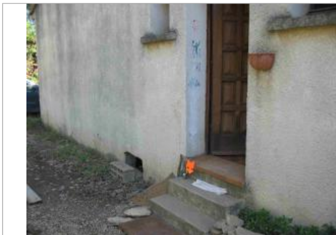
Vue du site - Auteur : Hydrologik Ingénierie
