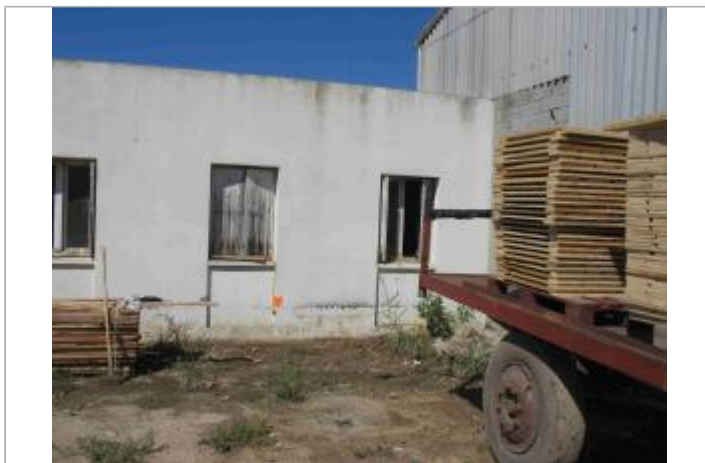
Vue du site - Auteur : Hydrologik Ingénierie
