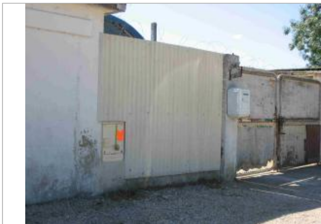
Vue du site - Auteur : Hydrologik Ingénierie
