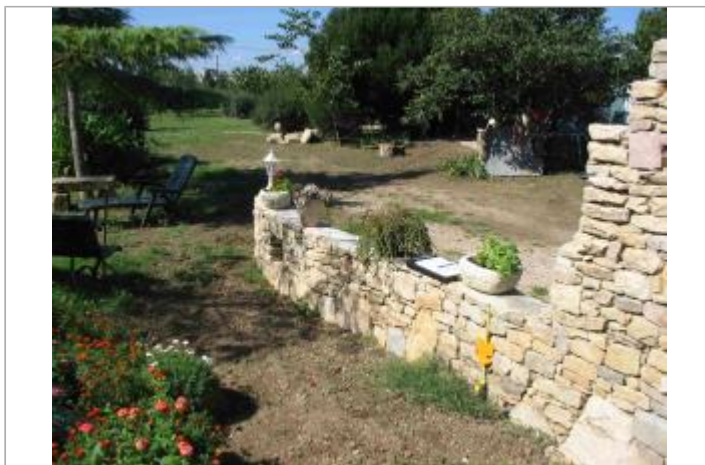
Vue du site - Auteur : Hydrologik Ingénierie
