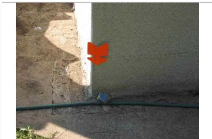
Photo du site - Auteur : Hydrologik Ingénierie
