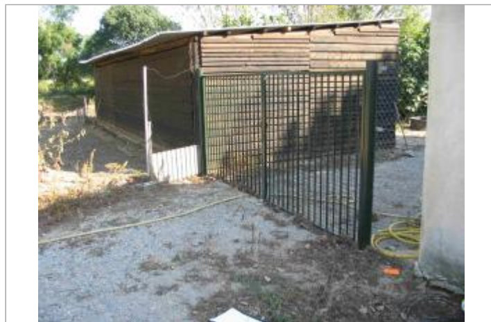
Vue du site - Auteur : Hydrologik Ingénierie
