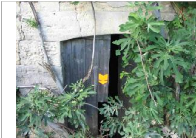
Vue du site - Auteur : Hydrologik Ingénierie
