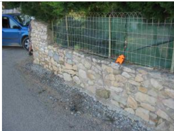
Vue du site - Auteur : Hydrologik Ingénierie
