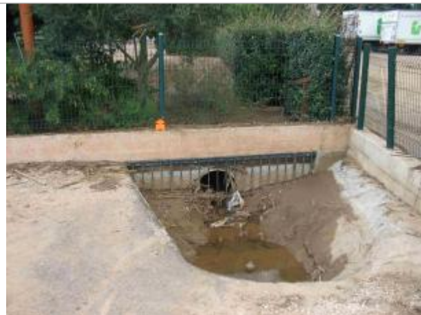
Vue du site - Auteur : Hydrologik Ingénierie
