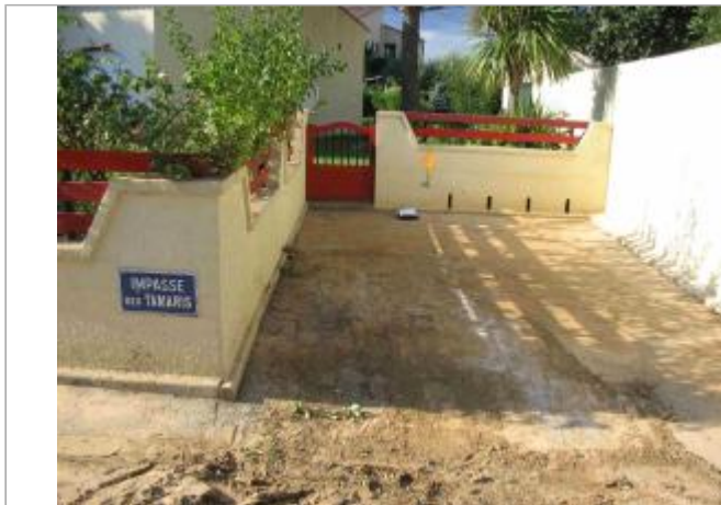
Vue du site - Auteur : Hydrologik Ingénierie
