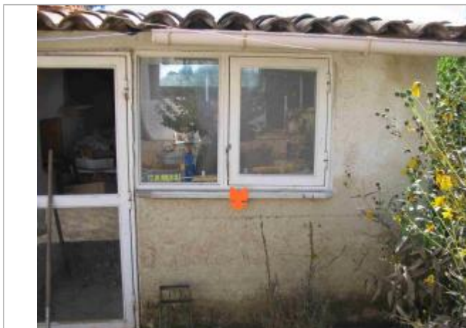
Vue du site - Auteur : Hydrologik Ingénierie
