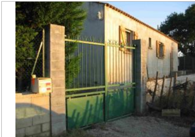
Vue du site - Auteur : Hydro Logik Ingénierie
