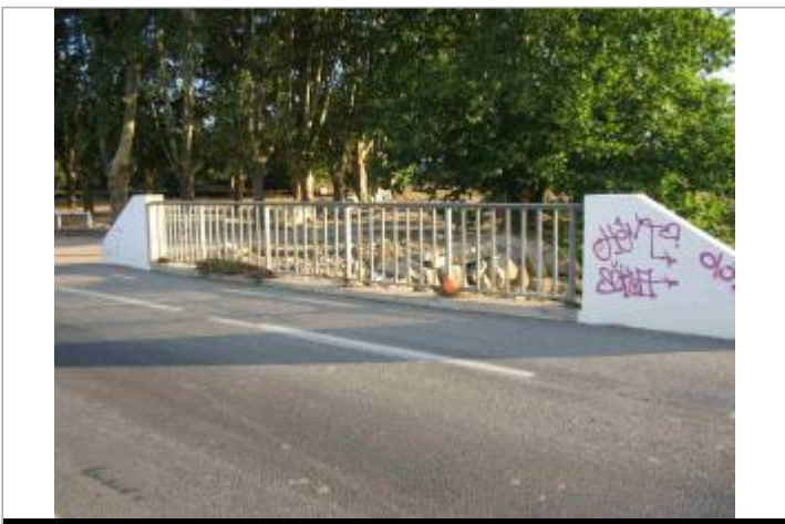
Vue du site - Auteur : Hydro Logik Ingénierie
