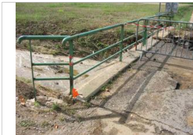
Photo du site - Auteur : Hydrologik Ingénierie
