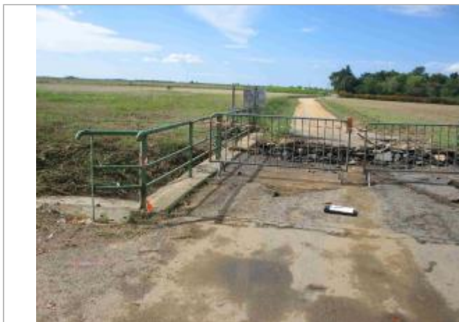
Vue du site - Auteur : Hydro Logik Ingénierie
