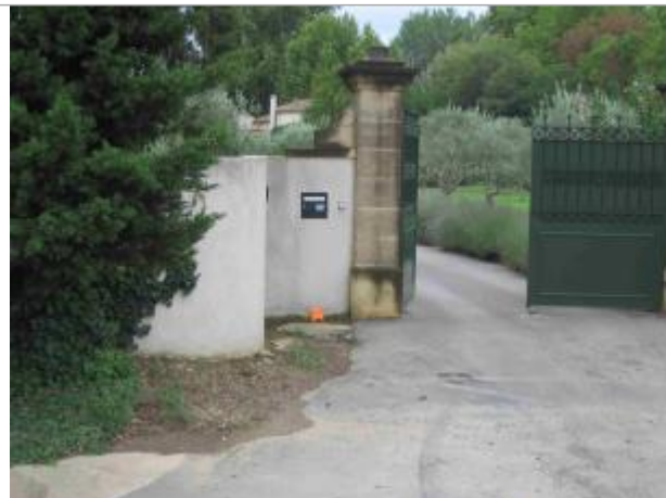
Vue du site - Auteur : Hydro Logik Ingénierie
