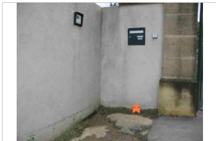
Photo du site - Auteur : Hydrologik Ingénierie
